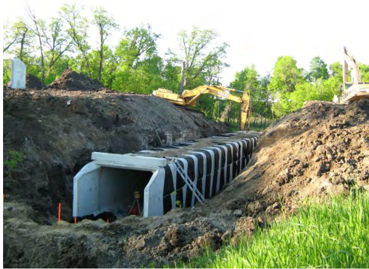
Polk CSAH #58 box culvert
